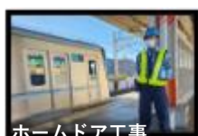
ホームドア工事
