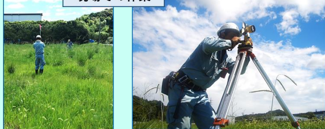
現場での作業
