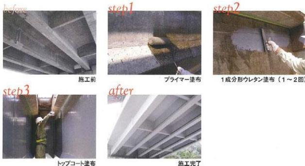
構造物の劣化に伴うコンクリートの剥落（はくらく）を防止する工事
