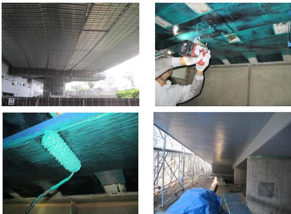
炭素繊維シートをコンクリート表面に張り付けて耐震補強を行う工事
