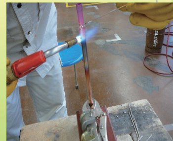
冷媒配管溶接
