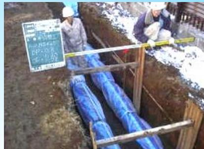
事前調査→試掘→掘削→布設替え→埋戻し→仮復旧→本復旧
