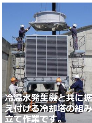
組み立てた冷却塔の屋上移動作業です。
