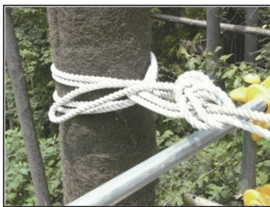
▲ 切断防止措置の例(置き型養生) ▲
