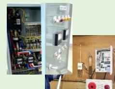
ボックス内にリレーやスイッチなどが集積された「制御盤」を作成します。また、火災報知器を例に、消防設備に関する法規や点検方法などを学びます。さらに、電気工事の実務で必要になる「低圧電気の特別教育」を取得します。
