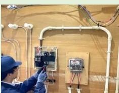
電気工事ではケーブルの施工だけでなく、管に電線を通して施工する工事もあります。金属や樹脂の電線管を加工して様々な電気工事の手法を学びます。また、電柱から建物内へ電気を引き込む工事や、ビルや商業施設などの大型施設の電気を制御する配線の方法を学び、建物全体の電気工事を行います。
