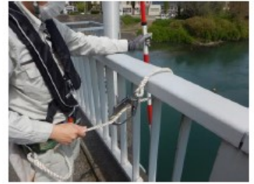
転落防止対策
