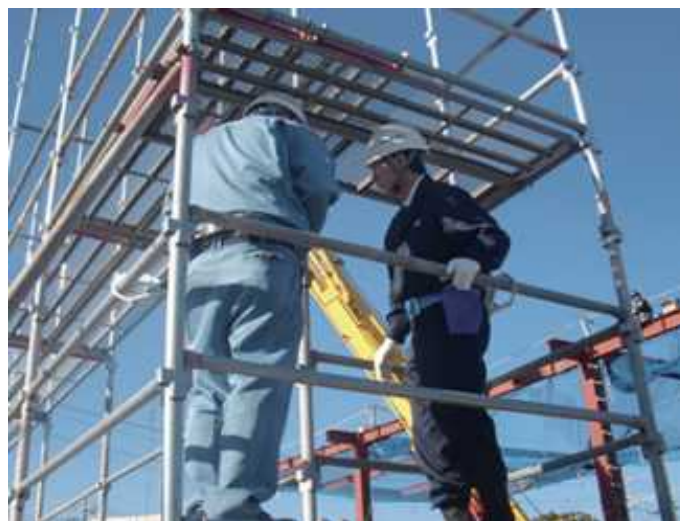
機械・設備、作業を確認
