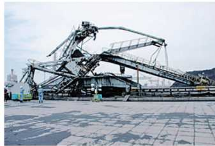
クレーンの崩落災害
