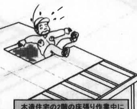
木造住宅の2階の床張り作業中に開口部に墜落して死亡した。
