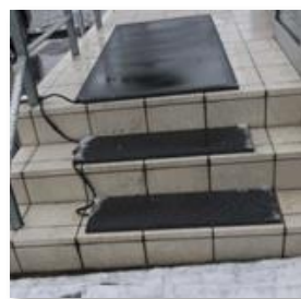
<ヒートマットの設置例>
