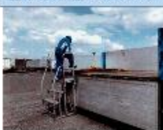
墜落・転倒防止：三点支持の徹底
