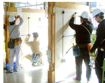
電気設備科 電気工事実習
