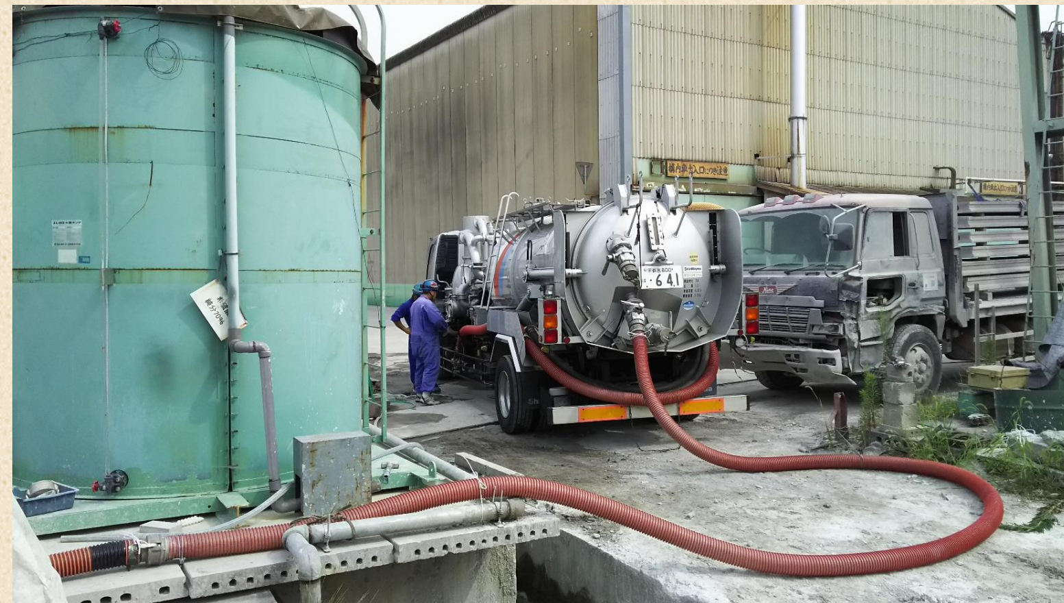
※高吸引車での吸引移送作業
