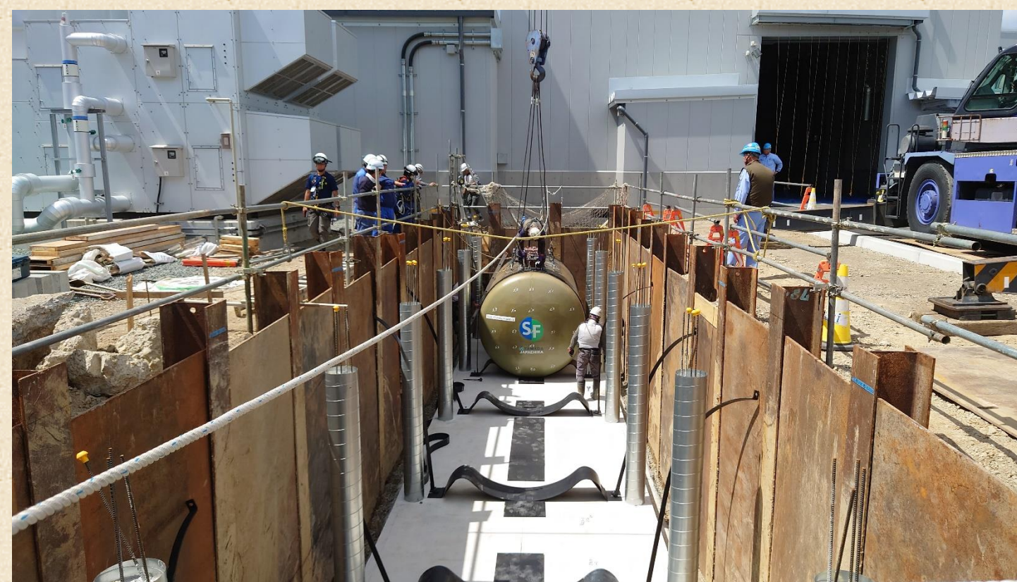
※原材料用地下タンク新設工事
