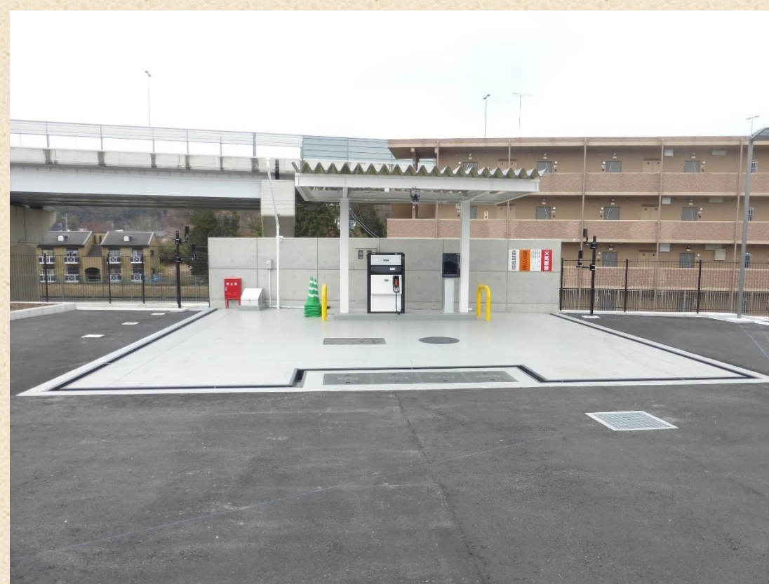
※自家用給油所新設工事
