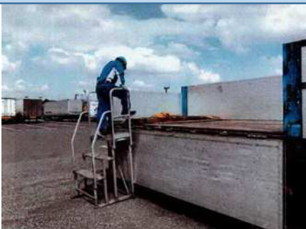
墜落・転落防止：昇降台の導入
