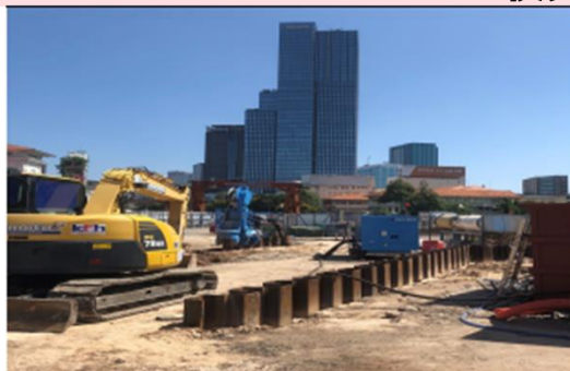
令和2年 ベトナム ホーチミンベトナム駅エントランス工事 平成29年より、海外プロジェクトにも参画しています。
