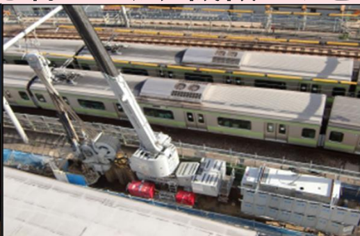
大塚・巣鴨間盛土耐震補強工事(山手線沿線) 狭隘地等、厳しい条件下での施工が得意です。
