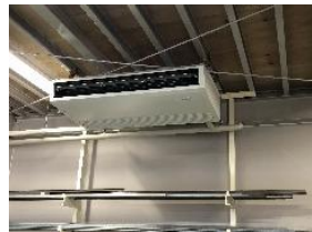
エアコン設置
