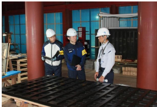
① 改修現場を確認する国分局長と横山署長
