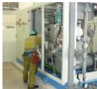
コンプレッサーメンテナンス作業
