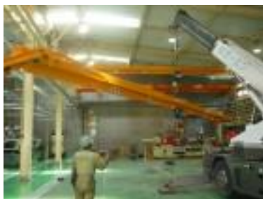
クレーン上架作業
