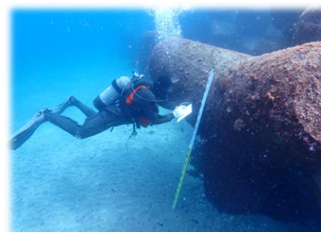
異常点調査・撮影(水中)
