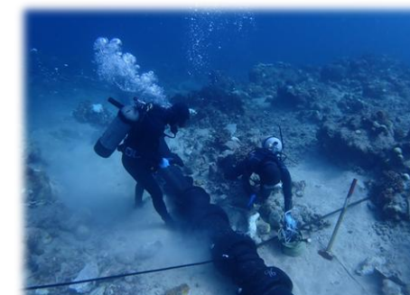
潜水軽作業(取付)
