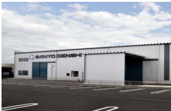
三洋電子株式会社の工場外観
