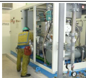
コンプレッサーメンテナンス作業
