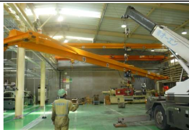
クレーン上架作業
