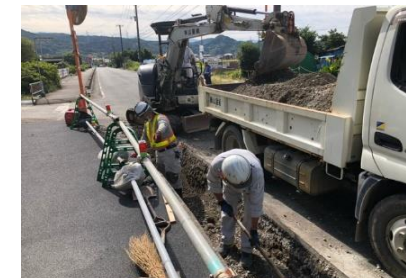
道路側溝の入れ替え
