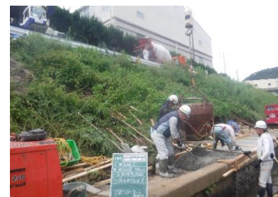
コンクリートの作業
