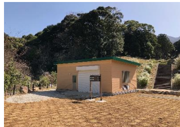
水力発電所の新築
