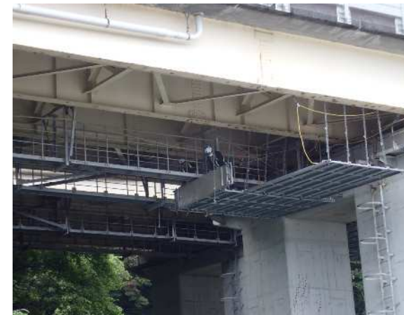
パネル組立状況
