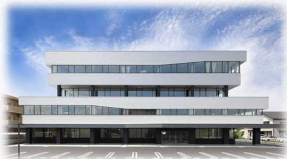
株式会社中筋組 社屋
