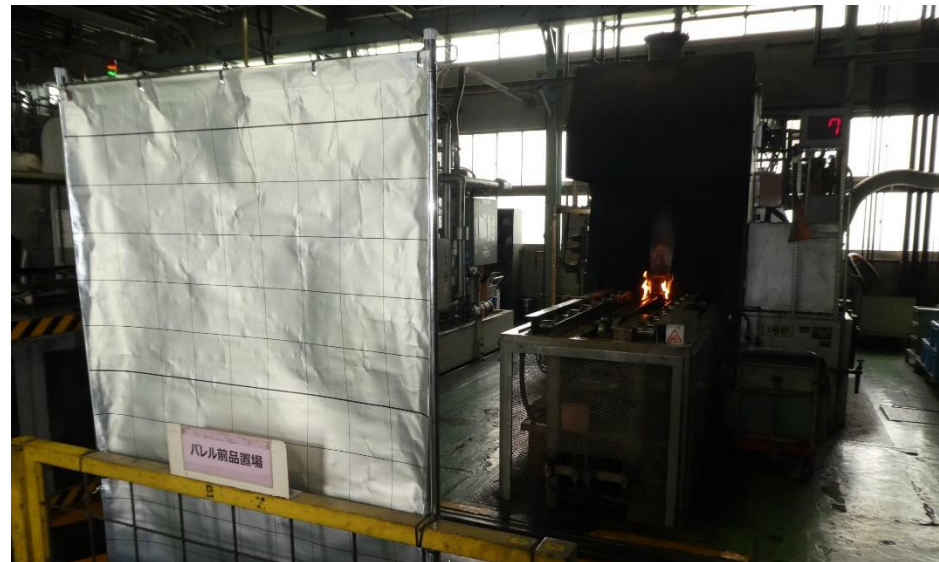
遮蔽板の設置により輻射熱を遮断
