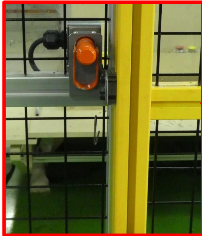
出入口は黄色で明示し、安全プラグを設置
