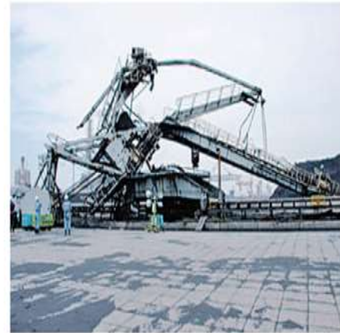
クレーンの崩落災害
