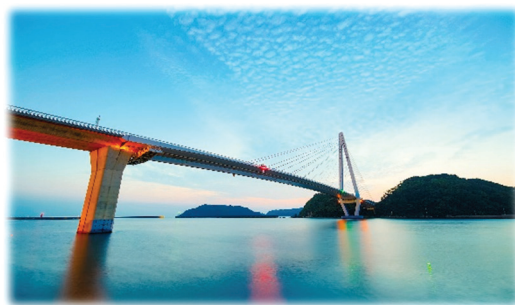
浜田マリン大橋(浜田市)
