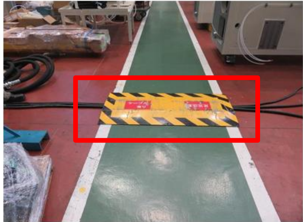
イ. ケーブルの上にカバーを設置した後の写真（改善後）
