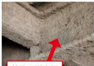
鉄骨の耐火用
