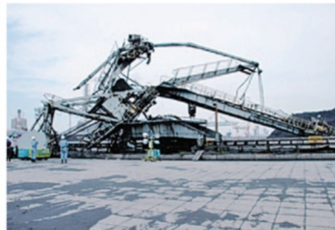
クレーンの崩落災害
