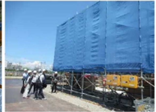
・足場の脚部滑動防止措置等の確認
