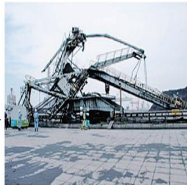
クレーンの崩落災害
