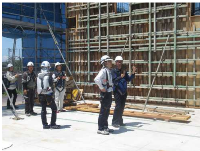
・1階部での転倒防止措置等の確認
