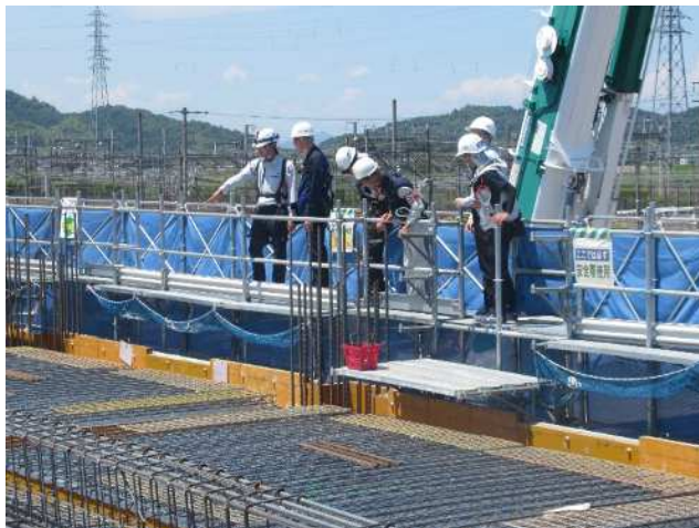
・2階部での墜落防止措置等の確認
