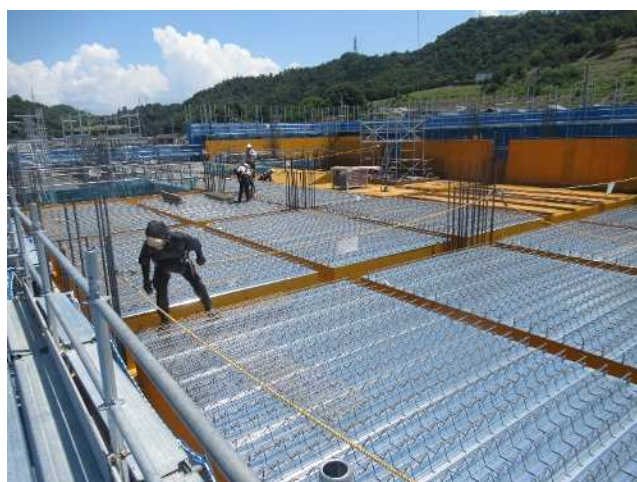
・手すり設置困難箇所へは親網が設置
