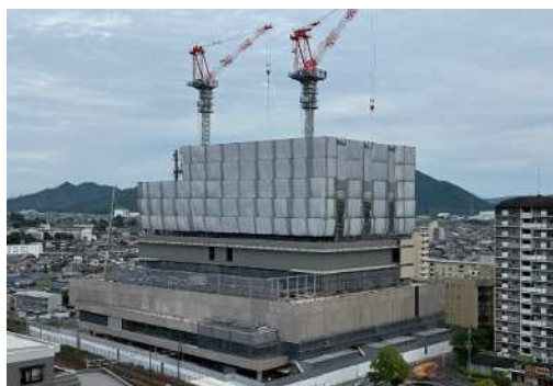
工事状況写真
