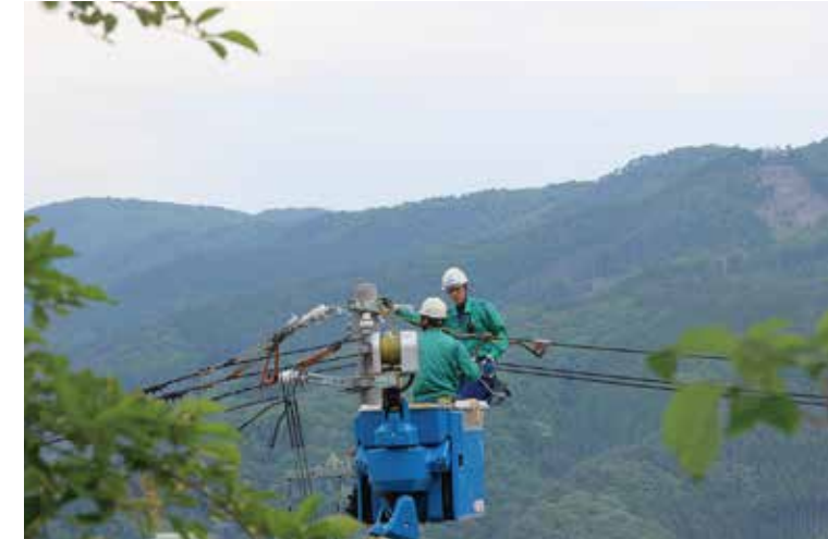
元請け会社ユアテックの業務発注に対応している。電柱や電線の新設・改修を手掛けるため高所での作業も多い
