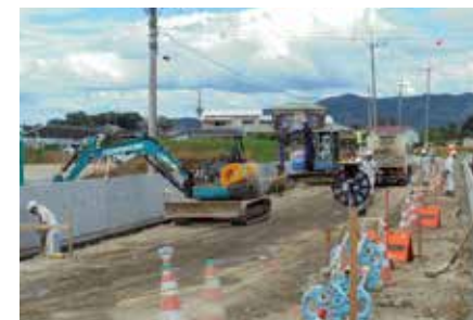
道路築造工事の土工作業風景
