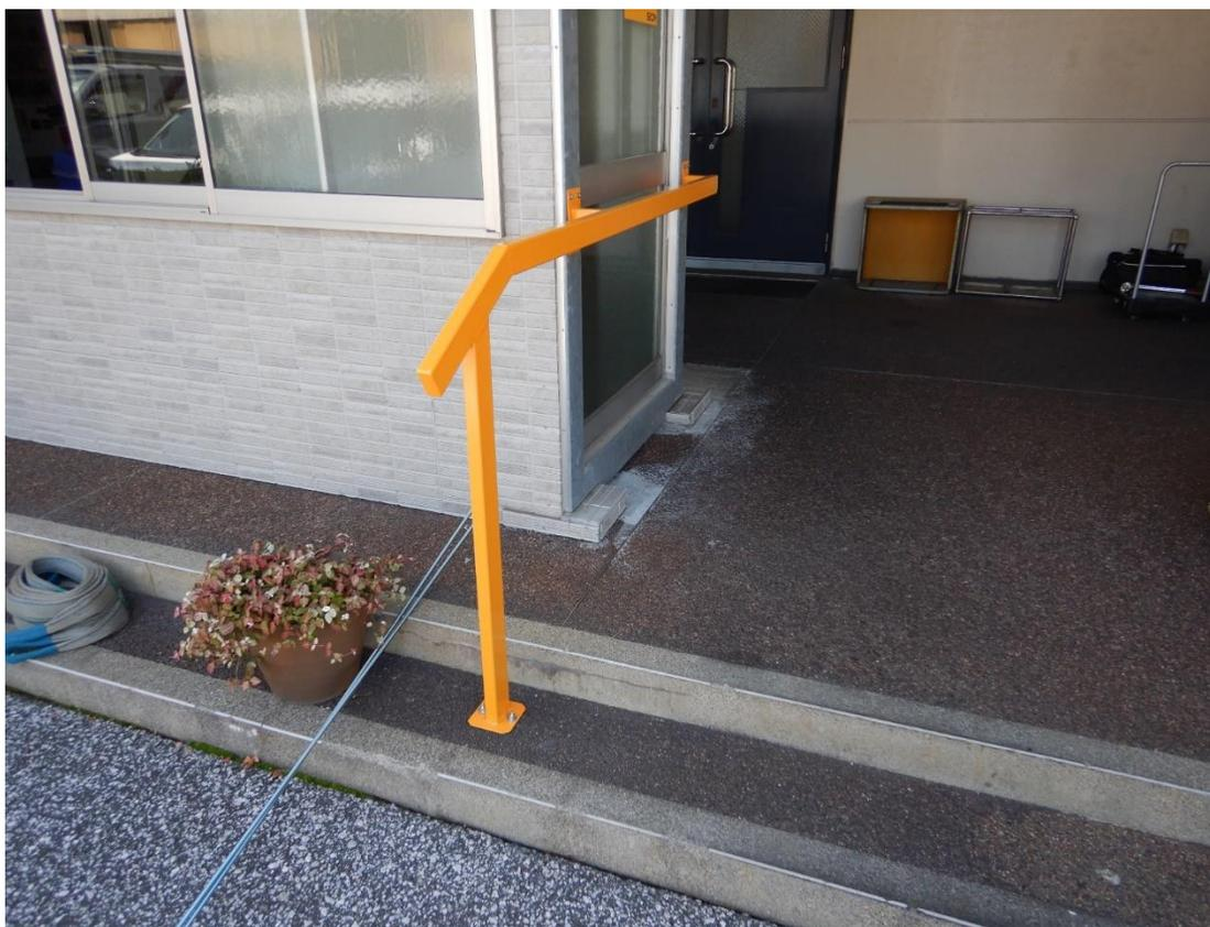
2段のステップに手すりを設け、視認しやすいように黄色塗装。
