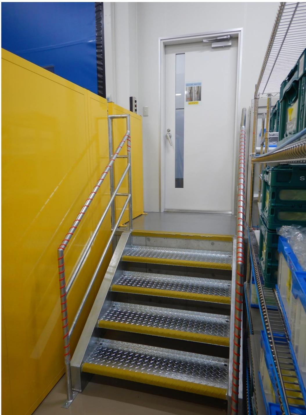
階段の全ての段の端を黄色塗装。
