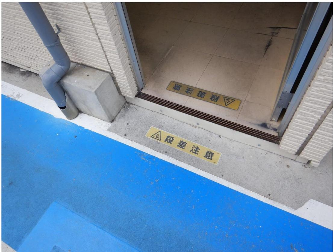
工場出入口の段差に「段差注意」の塗装（イラスト付き）。
