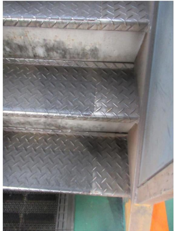
階段の全ての段に滑り止めシートを貼り付け。
