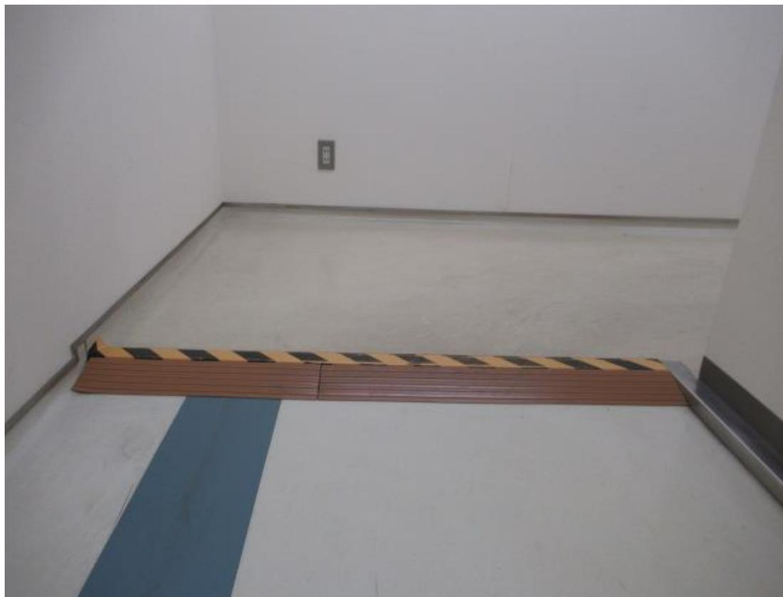
段差をスロープで養生し、トラテープを貼り付け。
