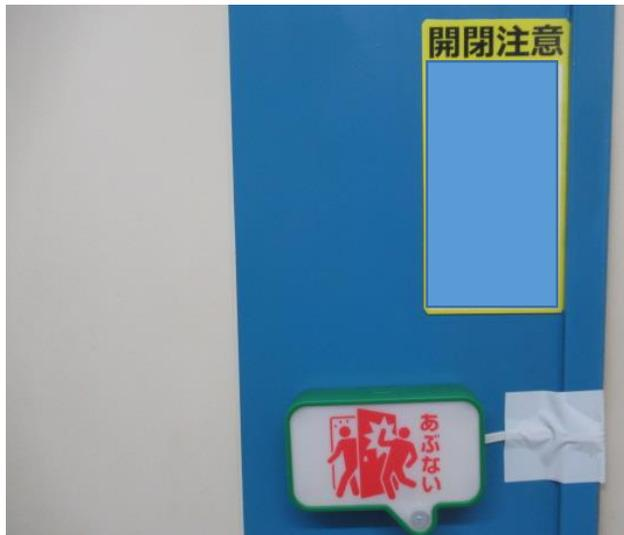
ドアの両側にセンサーを取り付け。感知すると点灯。開閉注意の掲示。
