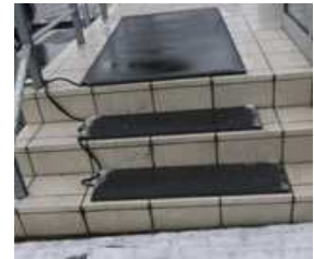
<ヒートマットの設置例>
