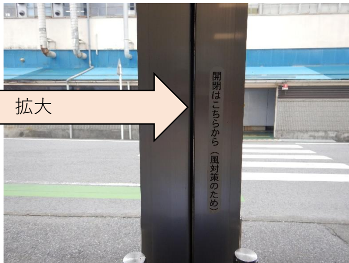
「開閉はこちらから」のシールを貼り付け。
