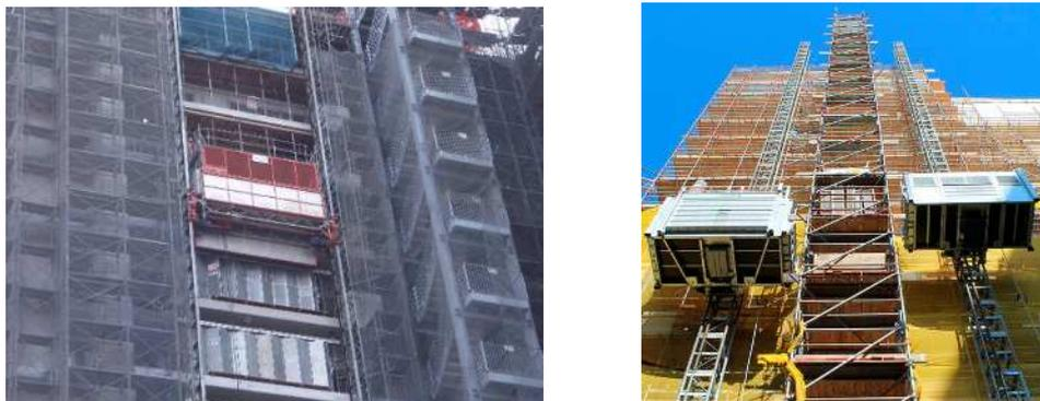
11号 ゴンドラ つり足場及び昇降装置その他の装置並びにこれらに附属する物により構成され、当該つり足場の作業床が専用の昇降装置により上昇し、又は下降する設備をいう。
