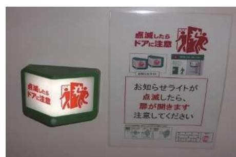
扉の周囲に人感センサーを設置。ライトの点滅によって扉が開くことを知らせ、扉付近での激突災害を防止しているもの。
