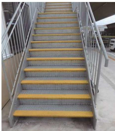
階段の踏み面の端部に砂を混ぜた塗料を塗ることにより、耐滑性を高めているもの（黄色の部分）。
