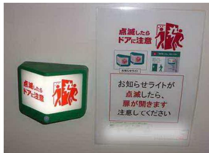
事例の概要 扉の周囲に人感センサーを設置。ライトの点滅によって扉が開くことを知らせ、扉付近での激突災害を防止しているもの。
