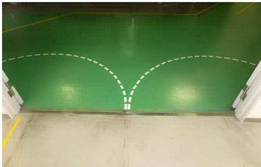
事例の概要 扉の開閉範囲を床面に示し、扉と歩行者等の接触防止を図っているもの。
