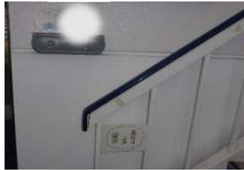
階段の上り口、下り口に人感センサーを設置し、歩行者に対して「手すりを持ちましょう」とのアナウンスを流しているもの。また、階段の両側に手すりを設けているもの。
