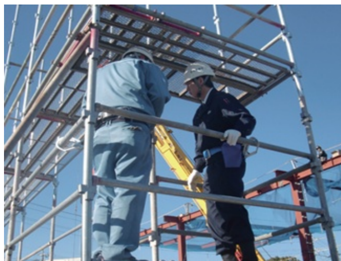
機械・設備、作業を確認
