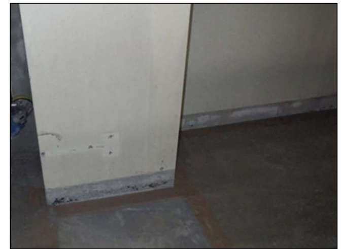
図-8-9：3階事務室内壁
