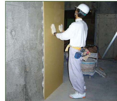
壁ボード取付状況
