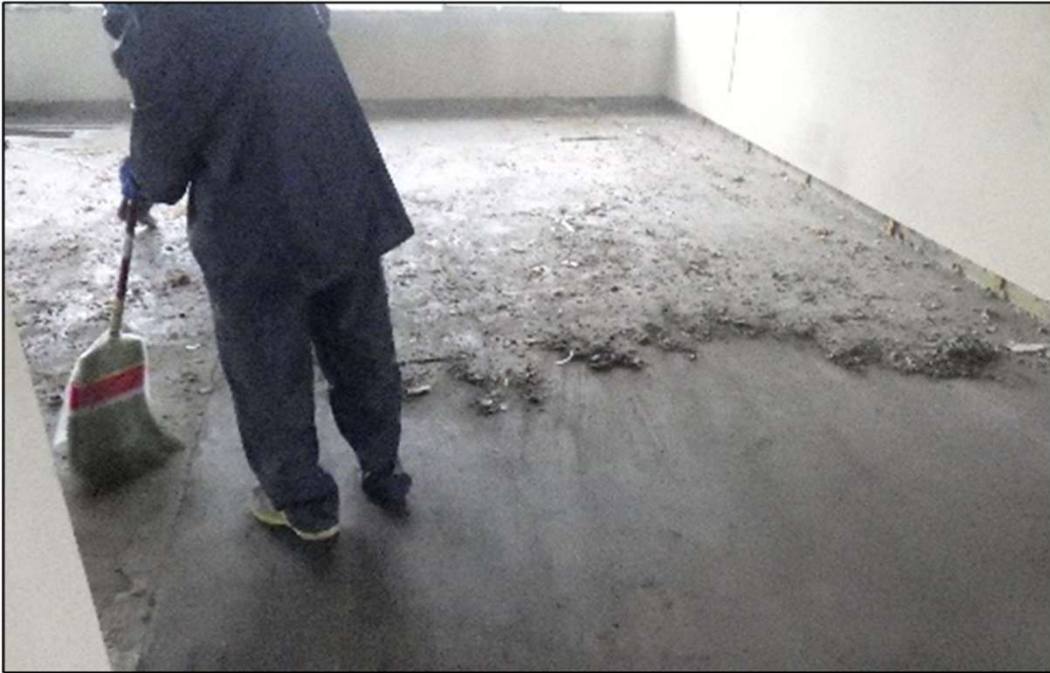
図-7-4：床面の清掃風景- 2
