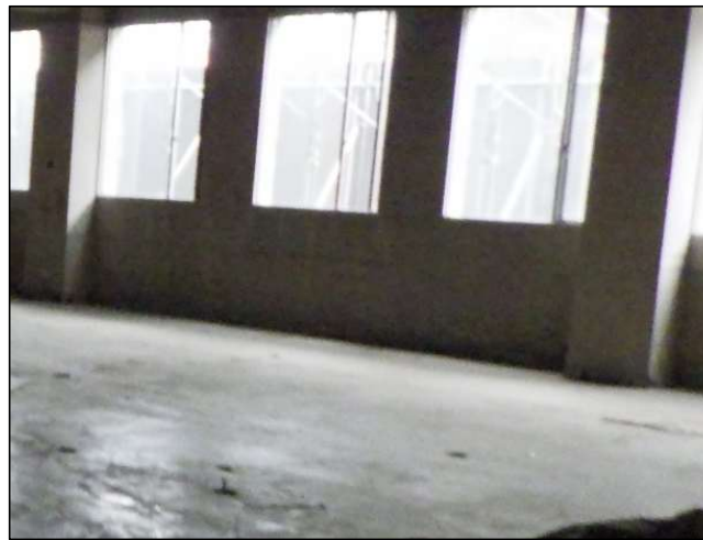
図-8-8：2階事務室内壁
