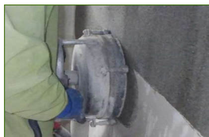
図-8-9：壁除去状況
