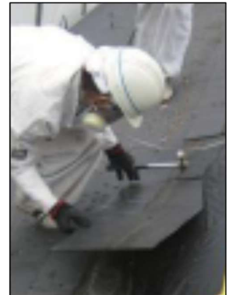
図-3-22：スレート板の取外し
