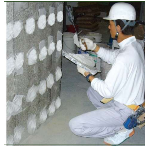
GLボンド取付状況
