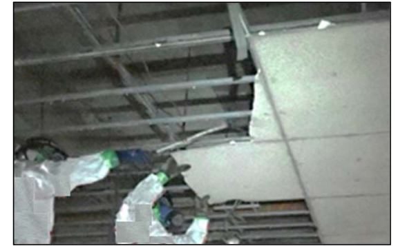
図-4-3：湿潤を行いながら手バラシ解体 (湿潤する人・解体する人)
