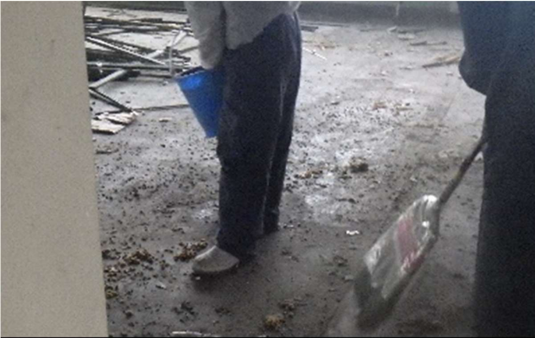
図-7-3：床面の清掃風景- 1
