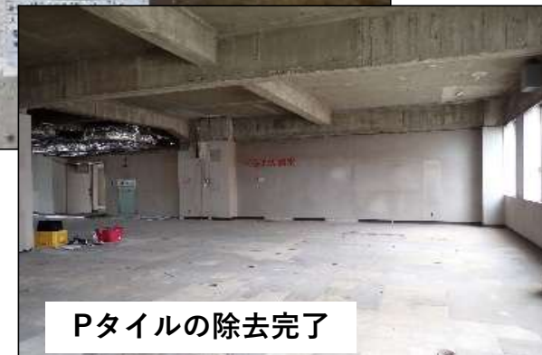
Pタイルの除去状況
