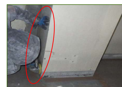
図-8-9：壁出隅除去状況
