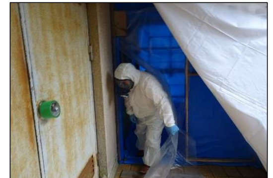
図-4-2：出入口：ビニール養生のみ
