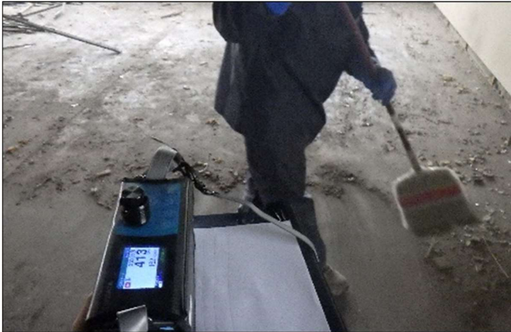
図-7-5：床清掃と粉じん測定- 1 (デジタル粉じん計による)
