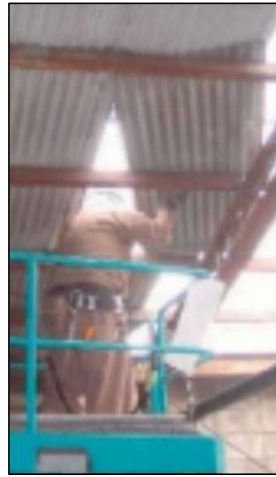
図-3-24 : スレート取外し
