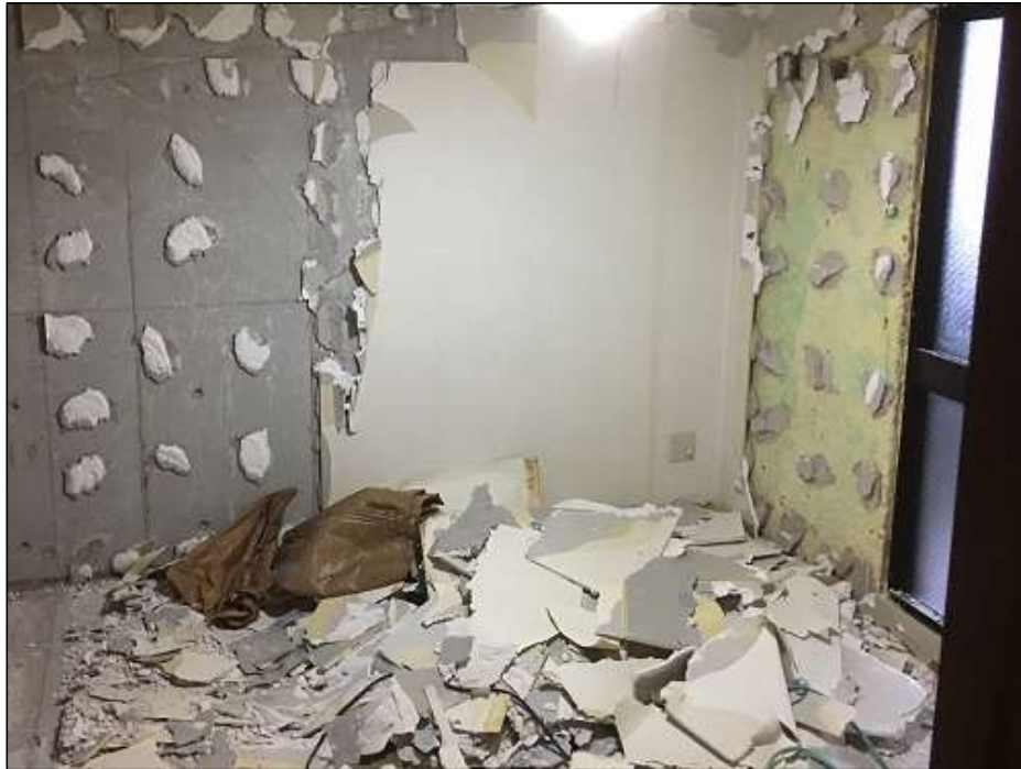
図-3-19：壁GLボード解体状況
