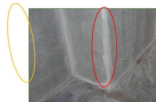
図-8-9：集じん装置付き超高压水洗機 の除去(出隅・入隅取残状況)
