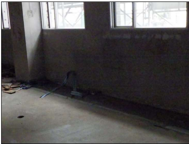
図-8-7：1階事務室内壁
