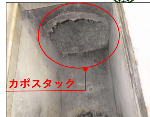
図-2-2：煙突内部写真
