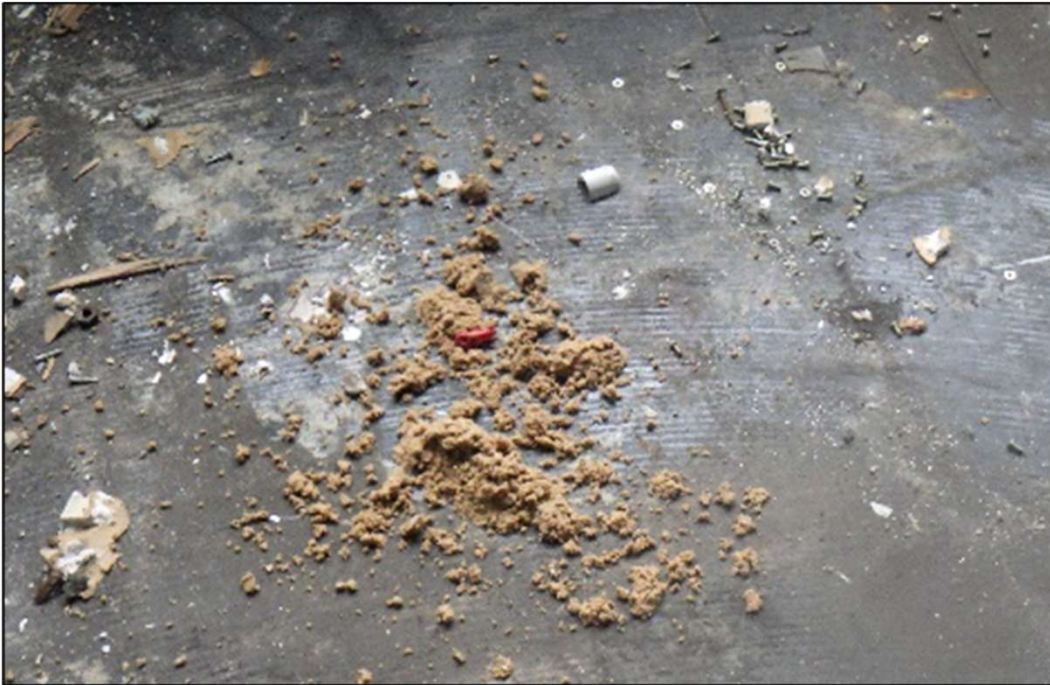
図-7-2：床面にオガクズを散布
