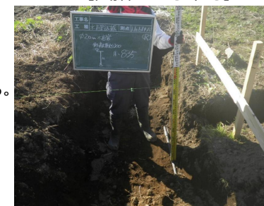
【試掘による確認】
