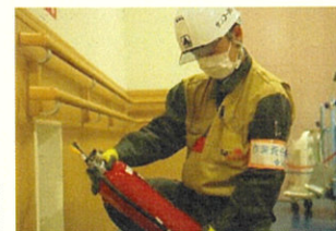
消防用設備の 点検作業現場
