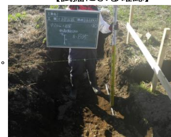
【試掘による確認】
